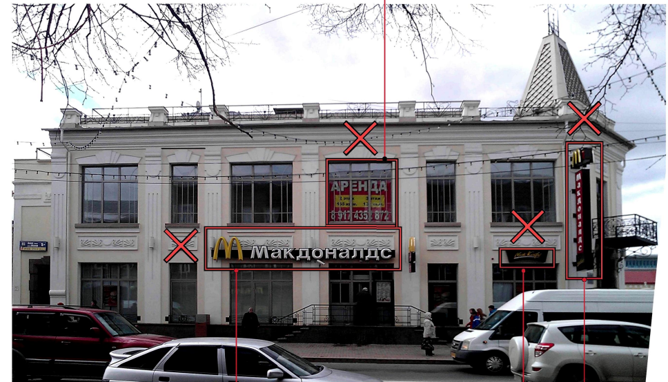
Фоторазвертка фасада с замечаниями
