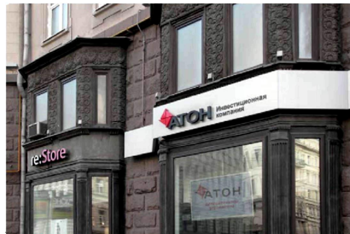
Вывески без подложки (слева) и с подложкой. Вывеска без подложки меньше закрывает фасад здания, поэтому является более предпочтительной
