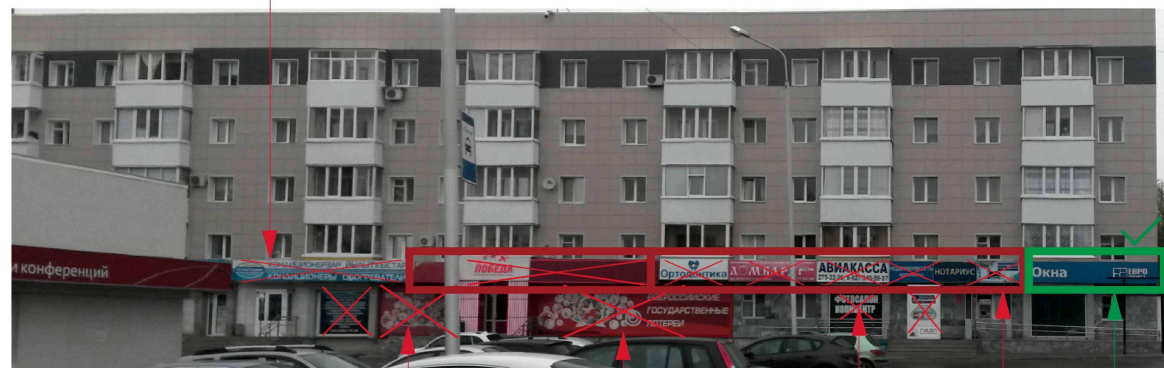
Фоторазвертка фасада с замечаниями
